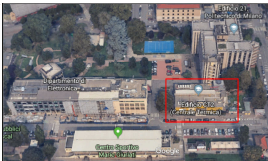
Fig. 2 - Centrale Termica, Politecnico di Milano
