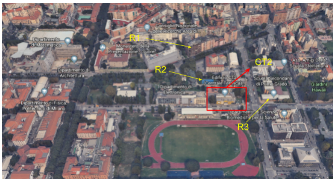
Fig. 14 - Individuazione dei recettori ubicati in prossimità della Centrale Termica CT2
